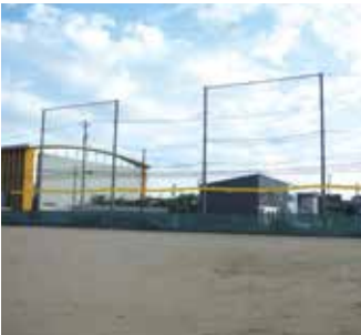
●ホームランライン施工(シート方式)
