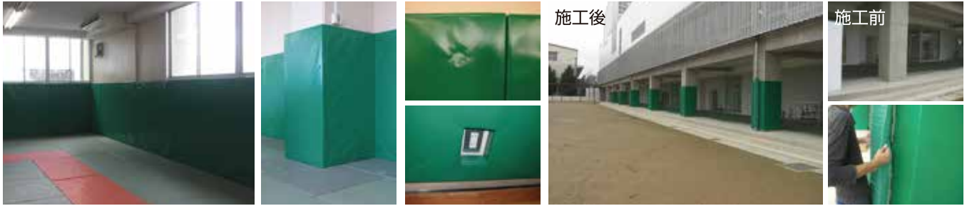
格技場 室内防護マット設置
