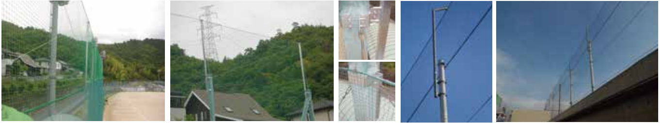
かさ上げ 角鋼管取付
