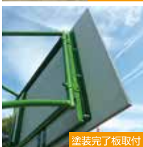
塗装完了板取付
